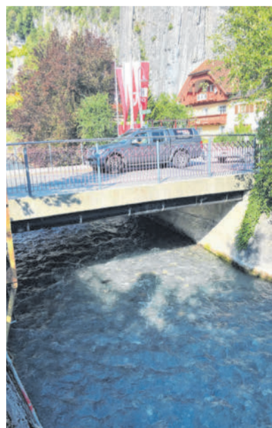
Landstraßenbrücke in Bürs muss für den Hochwasserschutz neu gebaut werden. VN/JS
