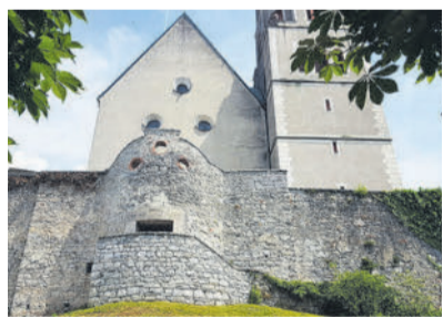
Aufwändige Sanierung des Naturmauerwerks. STB
